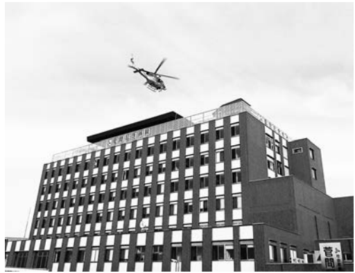
写真3 2015年には病院新棟がオープン。屋上にはヘリポートを設置
